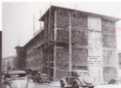
Neubau des Firmengebäudes in der Gymnasiumstrasse in Pforzheim
